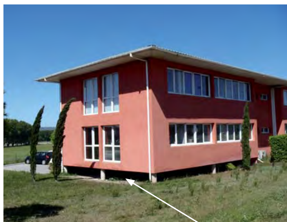
Adaptation du bâti en zone inondable - conception sur pilotis La Duranne à Aix-en-Provence
