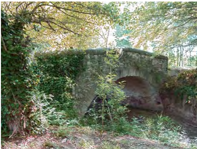
Vieux pont sur le ruisseau de l'Aigue Vive à Rousset
