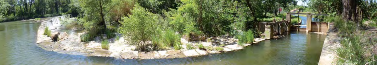
Prise d'eau au Moulin du Pont
