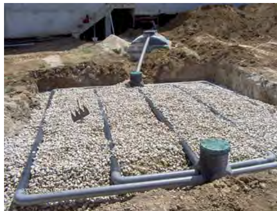
Exemple de système d'assainissement autonome
