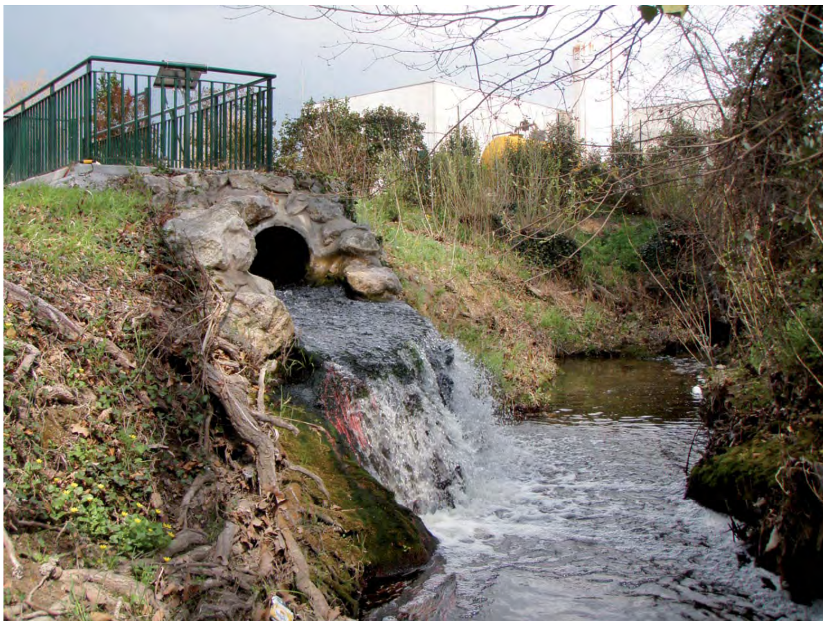
Rejet de la station d'épuration de Gardanne dans la Luynes
