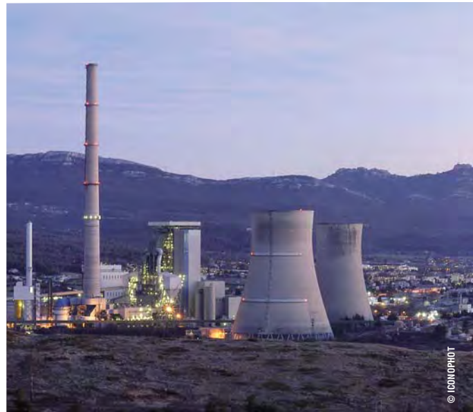
Centrale thermique à Gardanne
