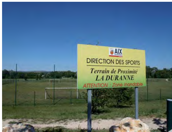
Bassin de rétention "multi-usages"
