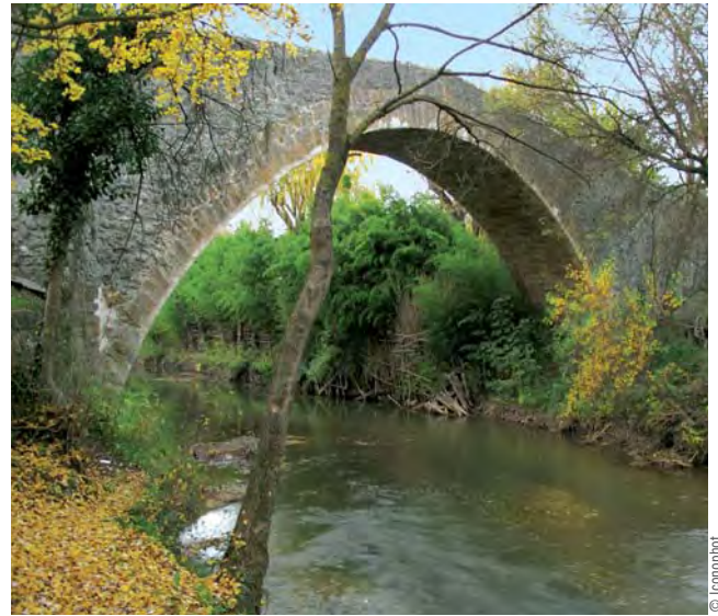
Le Pont des 3 Sautets, bâti au XIX ème siècle et classé monument historique, ce pont enjambe l'Arc à Meyreuil. Il a été rendu célèbre grâce aux peintures de Paul Cézanne
