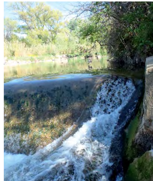
Rampe à anguille - Seuil de Gordes
