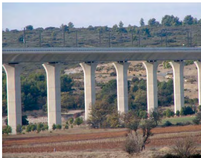
Ligne TGV - Viaduc de Ventabren / Equilles
